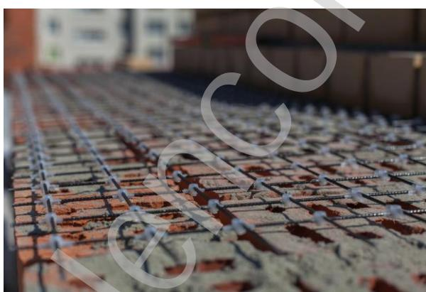
Рисунок 37. Укладка композитной сетки в кладку
