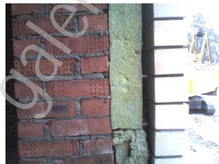
Рисунок 10. Применение связей в трехслойной стене с кирпичной облицовкой
